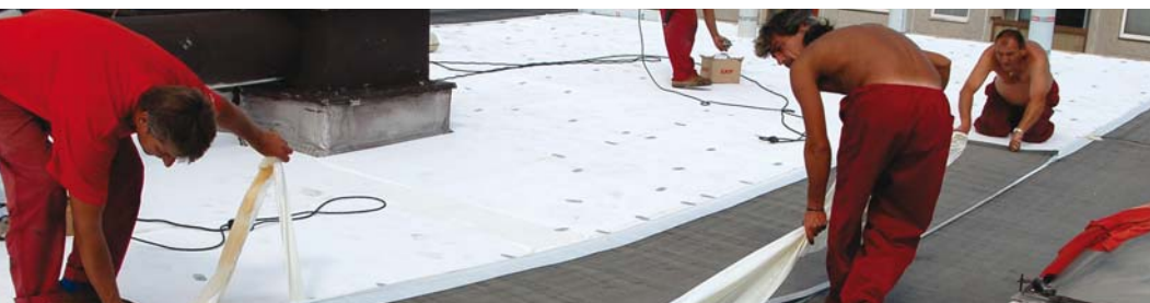
02 | skladba dvouplášťové střechy s pojistnou hydroizolací
